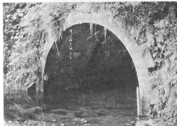
Le tunnel de Buret, vestige du Canal des Ardennes. (Photo D. Lefèbvre).
